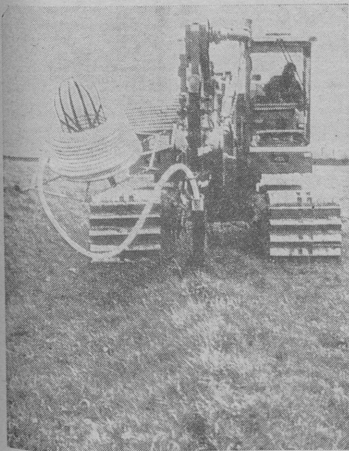
La drenadora de ruedas y, sobre todo, la de cadenas efectúan los perfiles del fondo de la zanja muy regulares. La drenadora de una reja SC 150 L, es una de las máquinas premiadas en la Sima de París, en marzo de este año.
