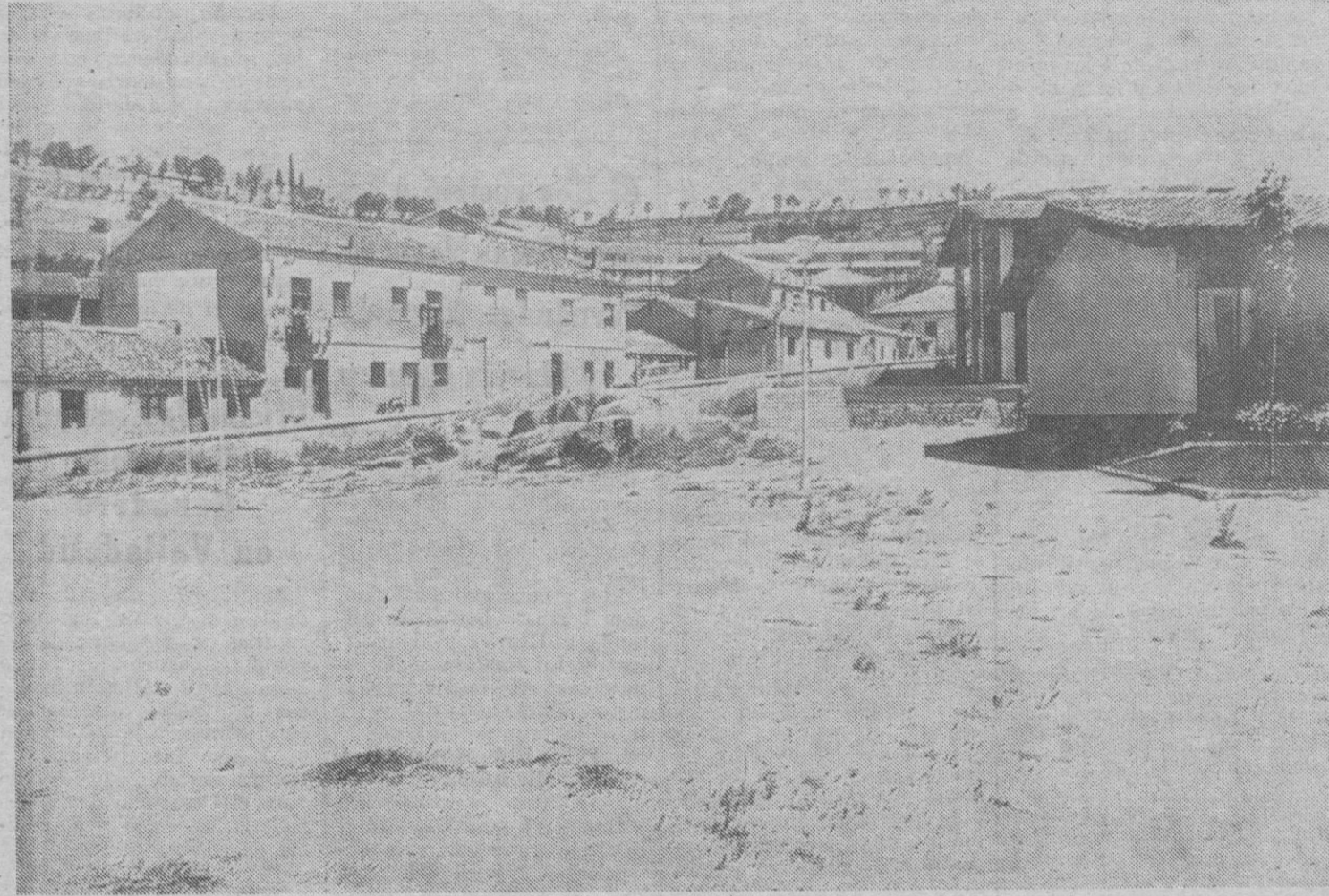
Estos son parte de los terrenos que se ocuparán con las nuevas aulas
