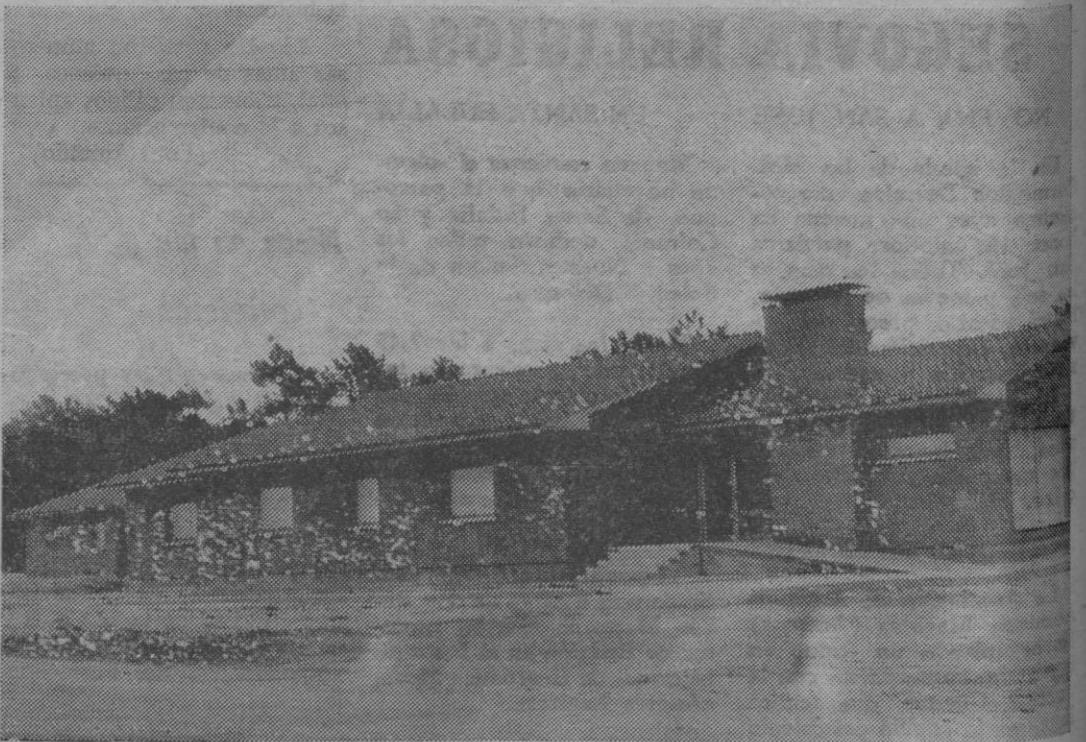
Este es el edificio del nuevo Centro Sanitario Subcomarcal, que se espera entre en funcionamiento, en Cantalejo, en fecha próxima
