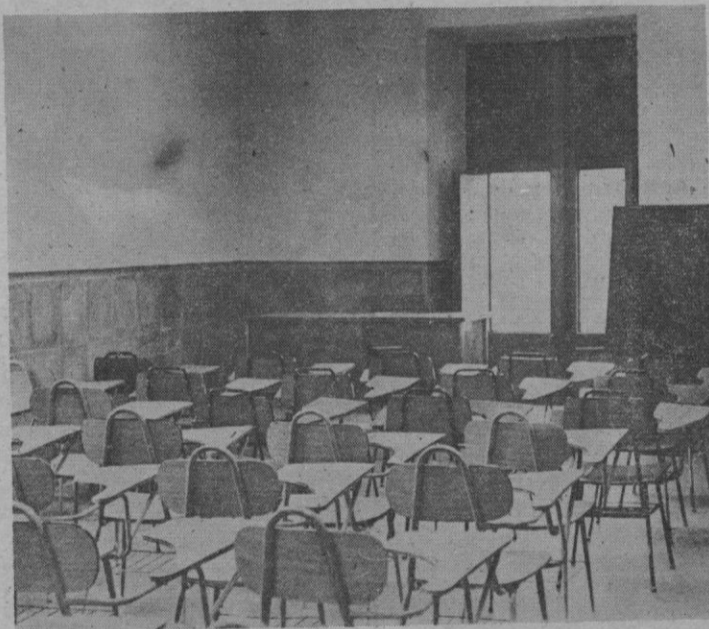
Una de las aulas del Colegio
