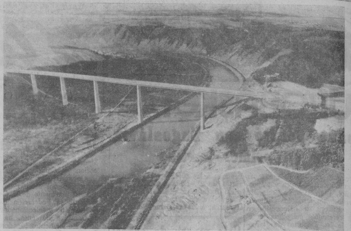
Coblenza.—Este es el puente de autopista más alto de la República Federal de Alemania. Con una longitud de 935 metros, sobre el valle del Mosela, une, a una altura de 136 metros, dos montañas de mediana altura. A pesar de sus dimensiones gigantescas, la obra causa la impresión de un juguete.—(Foto DaD)
