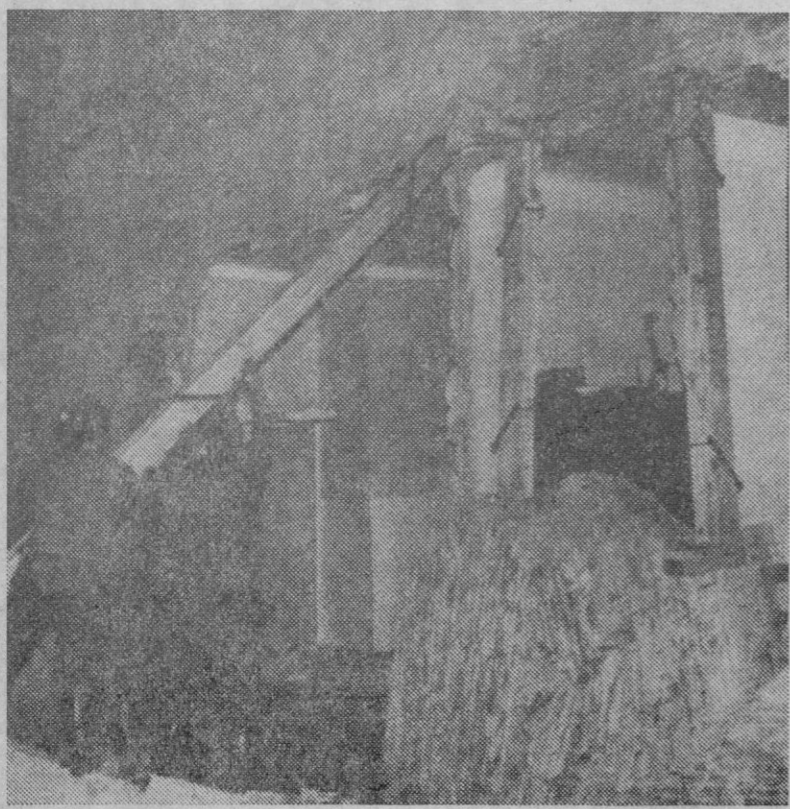
La finca situada en el núm. 36 de la calle madrileña del General Pardiñas sufrió un hundimiento como consecuencia de las obras que se realizan en un solar contiguo. En la foto, los bomberos apuntalan las paredes de la casa. No hubo desgracias personales
