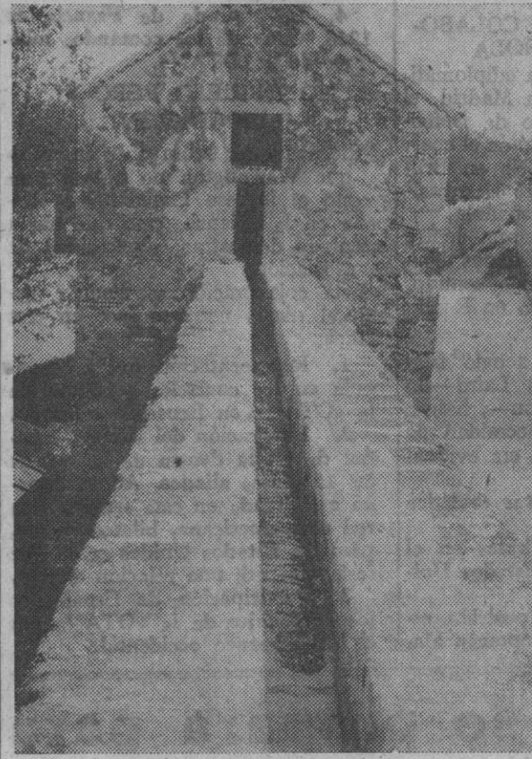
El agua, apenas iniciado su recorrido por el canal romano, sale del Desarenador camino del acueducto propiamente dicho
