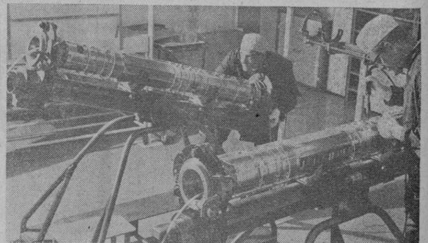
Técnicos trabajando en talleres climatizados y libres de polvo, montan y prueban dos repetidores de cable submarino. Los repetidores son, simplemente, minúsculos transmisores-receptores encerrados en el cable telefónico submarino, que captan, amplían y retransmiten las señales al repetidor más cercano, posibilitando las conferencias telefónicas con países muy distantes entre sí.
