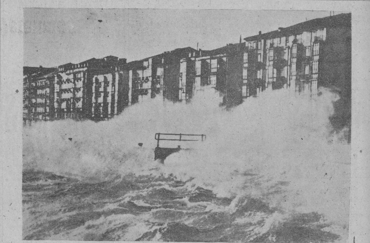
Un violento vendaval ha azotado las costas del Norte de España. Las olas de la bahía de Santander saltan sobre el maricón y llegan hasta las fachadas de los edificios del paseo Pereda.—(Foto Fiel.)
