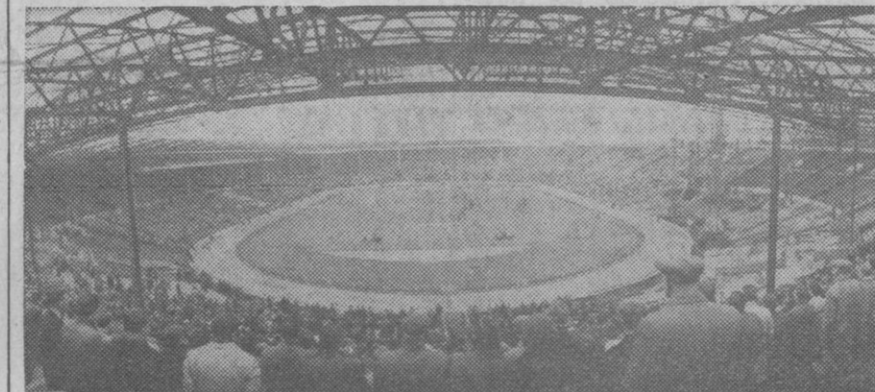
En esta fotografía se ha captado una inusitada vista del "Wembley Stadium" londinense. Este gran coliseo del fútbol en Inglaterra está actualmente sometido a una magna transformación, a medida que sus andanadas van sotechándose por una vastísima marquesina oval, de viguetas y techumbres de blástico. Cuando se finalicen las obras, Wembley, que ofrece capacidad para cien mil espectadores, será el stadium cubierto mejor del mundo
