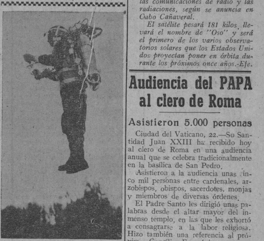
Harold H. Graham, ingeniero de pruebas de la Bell Aerosystems, de Buffalo, Nueva York, demuestra el funcionamiento del "cohetillo" En las distintas pruebas realizadas saltó un arroyo y un montículo de nueve metros de altura y realizó vuelos de hasta ciento diez metros de distancia. El dispositivo puede desplegar una velocidad máxima de treinta kilómetros por hora, va impulsado por un doble cohetillo de propulsión a base de peróxido de hidrógeno
