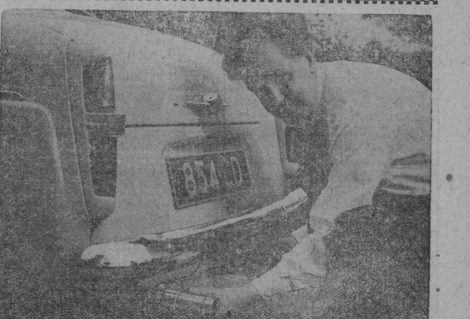
El investigador científico británico Charles Henry Nottage viene combatiendo desde hace siete años los gases de escape de los vehículos motorizados. Ha inventado un purificador que aparece en el gráfico colocado en el tubo de escape de su automóvil. El dispositivo convierte el humo negro de escape en un fino polvo, que se extrae periódicamente (tras unos ocho mil kilómetros de funcionamiento). Cuando se trata de depósitos cargados de aceite, un canal situado en la parte inferior del dispositivo colecta el exceso de humedad, que más tarde se desprende en forma de gotas.
