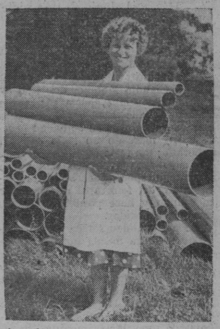
Actualmente se produce en Gran Bretaña un nuevo tipo de tuberías plásticas—tan livianas que las puede transportar una muchacha y, al mismo tiempo, mucho más resistentes que las tuberías plásticas corrientes—, de diámetros comprendidos entre 1,27 y 30,4 centímetros. Resistentes a la corrosión y pesando sólo la quinta parte de las de acero, las nuevas tuberías resisten fuertes golpes
