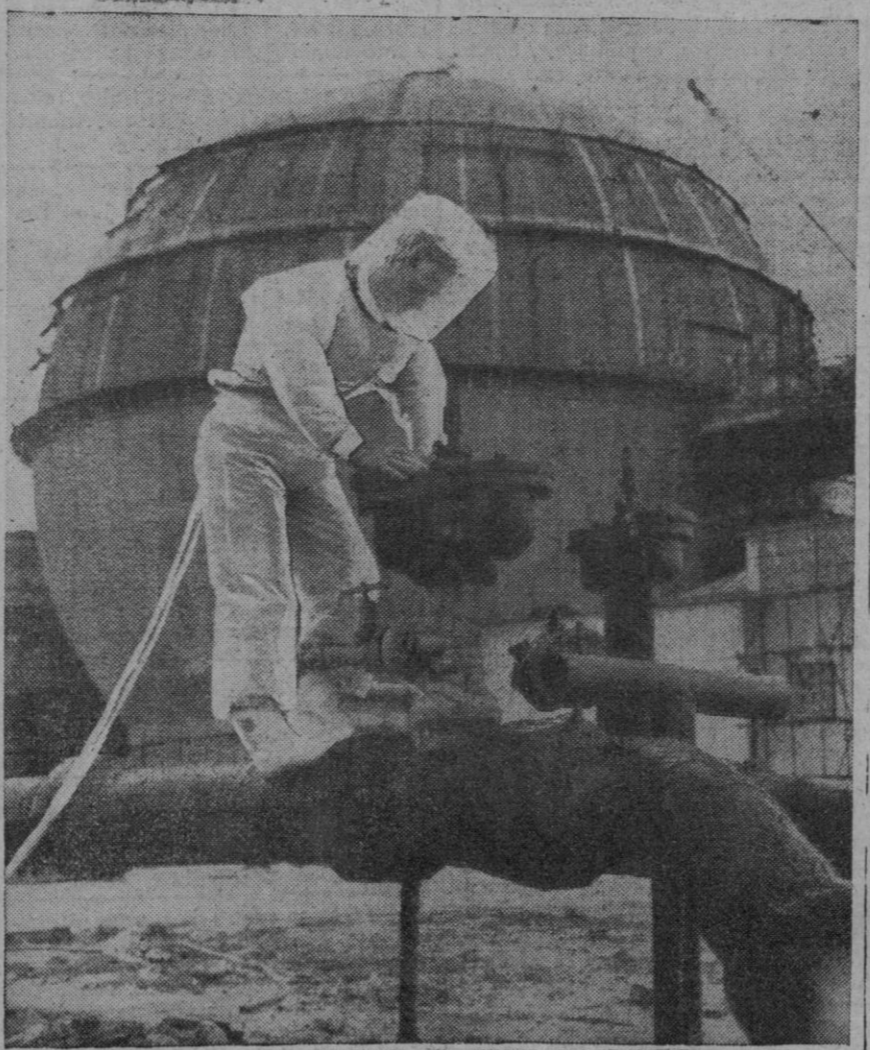
Un capataz de seguridad de una central eléctrica inglesa, que viste un traje protector presurizado, haciendo una investigación práctica de válvulas que, se supone, están contaminadas por un derrame radiactivo. En el fondo aparece la gran esfera, herméticamente cerrada, que contiene un reactor reproductor rápido; mide 40,5 metros de diámetro, tiene un área de superficie de 6,070 metros cuadrados y pesa mil quinientas toneladas. Su objeto básico es incrementar el uso eficiente del uranio, de modo que una tonelada de este elemento proporcione la energía de la combustión de un millón de toneladas de carbón, en lugar de producir la de diez mil toneladas, como ocurre en la central de Calder Hall
