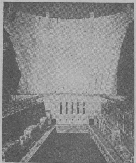
La presa Grand Coulee. Es esta una mole de más de 8.571.222 metros cúbicos de hormigón y tiene una altura de 168 metros, siendo su longitud de 1.280 metros. Esta presa alimenta una batería de dieciocho generadores capaces de mantener una producción de dos millones de kilovatios por lo menos.
