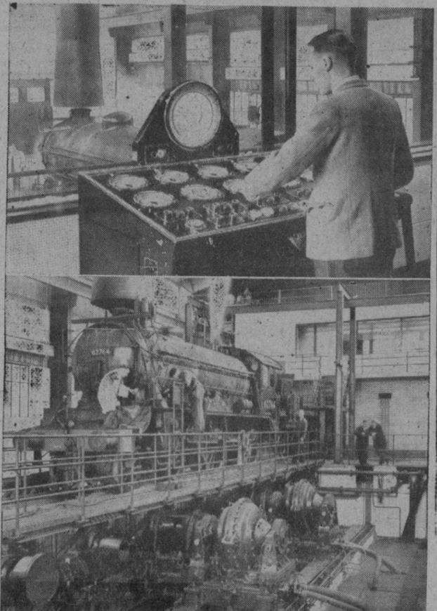
La estación de ensayo para locomotoras de los caminos de hierro de Inglaterra, es la más moderna, no existiendo en el mundo más que tres de este género. En la parte superior de la fotografía, un ingeniero en la mesa de control; en la parte inferior, una locomotora en la sala de pruebas de la estación de Rugby (Inglaterra). La máquina marcha como la haría sobre la vía férrea, e instrumentos complicadísimos registran la velocidad alcanzada por aquella
