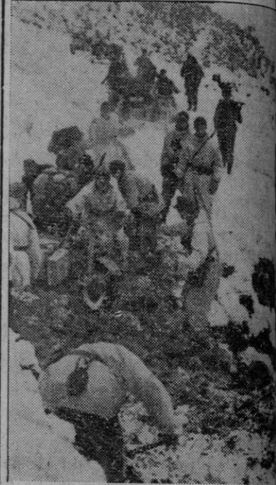
Al avance de las tropas alemanas se opuso un obstáculo preparado por francotiradores. Los zapadores del Reich trabajan para dejar expedito el camino.
