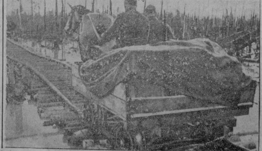
Para poder realizar el transporte por los terrenos pantanosos de Rusia, las tropas alemanas han construido estas toscas vías con maderos, por las que marchan los carros
