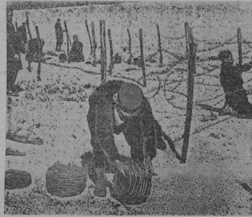
Soldados de Ingenieros, italianos, construyendo alambradas delante de las líneas avanzadas en Libia
