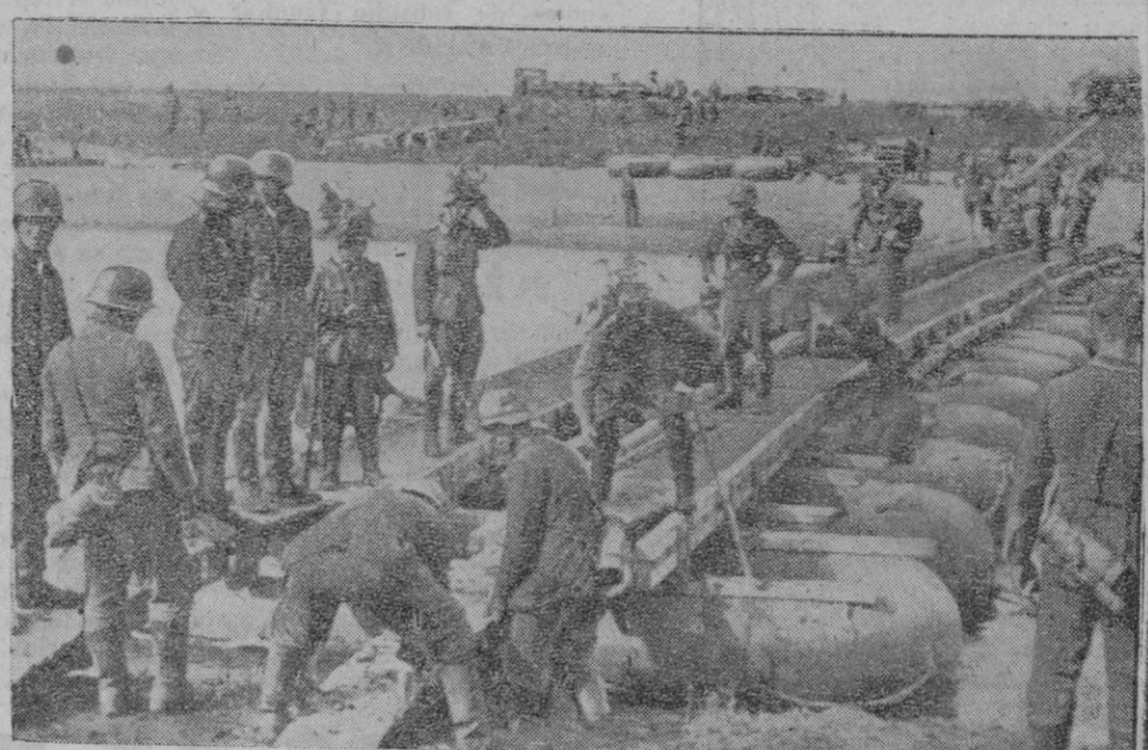
En el frente meridional ruso, donde se desarrolla la actual ofensiva, por sus numerosos ríos, es de suma importancia el trabajo de los pontoneros. He aquí un puente sobre botes neumáticos que han establecido los pontoneros alemanes para el paso de la infantería y unidades ligeras motorizadas.
