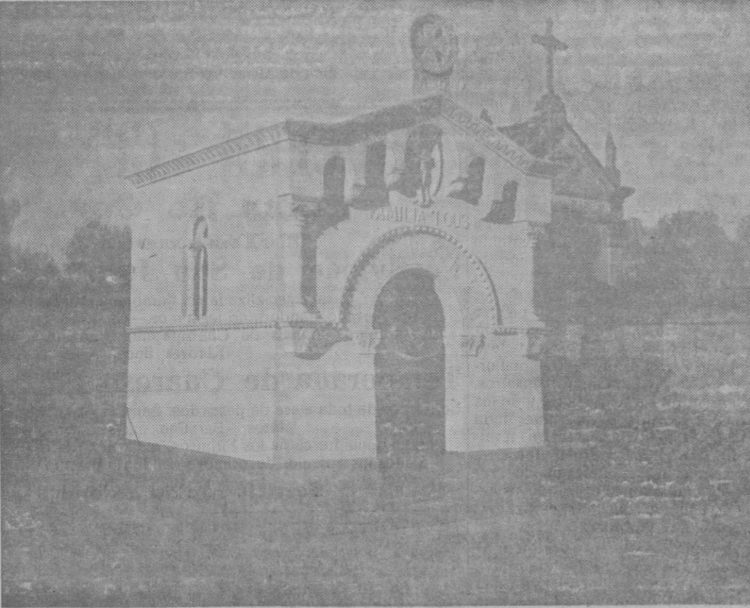
Capilla de estilo romántico que el escultor de Muro, D. Antonio Perelló, ha construido para el cementerio de Santa Margarita por encargo de la familia Tous Lliteras.
