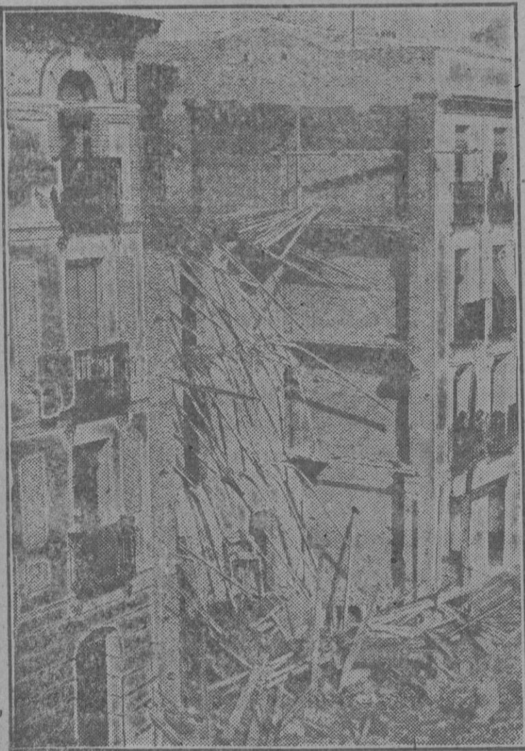
La casa en construcción de la calle de Topete que se hundió
