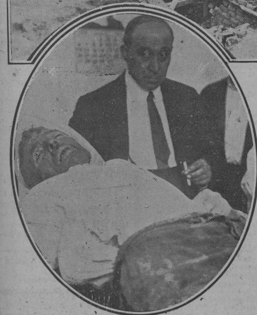
Fuerzas de la Guardia Civil custodian el sitio donde ocurrió el hundimiento que costó la vida a un obrero. En el óvalo, el infeliz obrero Rogelio Martínez, que murió entre los escombros al hundirse las obras del Metro en la glorieta de los Cuatro Caminos
