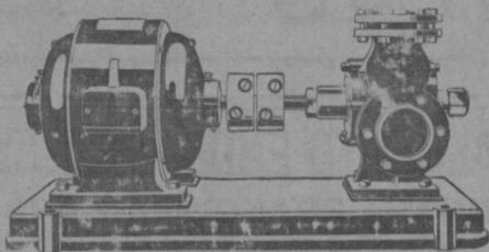
**Ideal** para usos domésticos. 500 litros de agua por hora a 40 metros altura. Acoplada a motores **monofásicos** de 1/4, 1/6 y 1/8 de HP. que puede conectarse a líneas ordinarias de luz. La **Bomba Prat** sirve perfectamente para el trasiego de vinos y aceites. Innumerables referencias en Palma. Grandes existencias de los grupos más corrientes. Calefacción. Pilas y estuches de todas clases. Taller de galvanoplastia.
