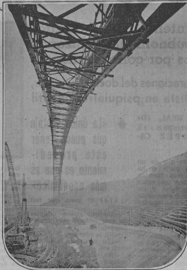
estructura metálica con luz libre, entre apoyos de 115 metros
