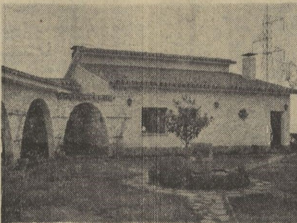
Este es el chalet del matrimonio Hanohs, construido en la finca de 40.000 metros cuadrados, propiedad del sabio atómico.
