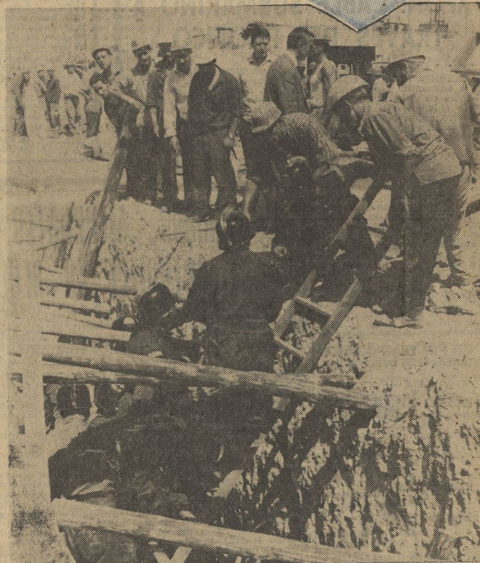
Cuatro obreros han resultado muertos esta mañana al derrumbarse sobre ellos un muro de una galería de servicios en construcción. (Foto Boutellier.) (Pág. 32.)
