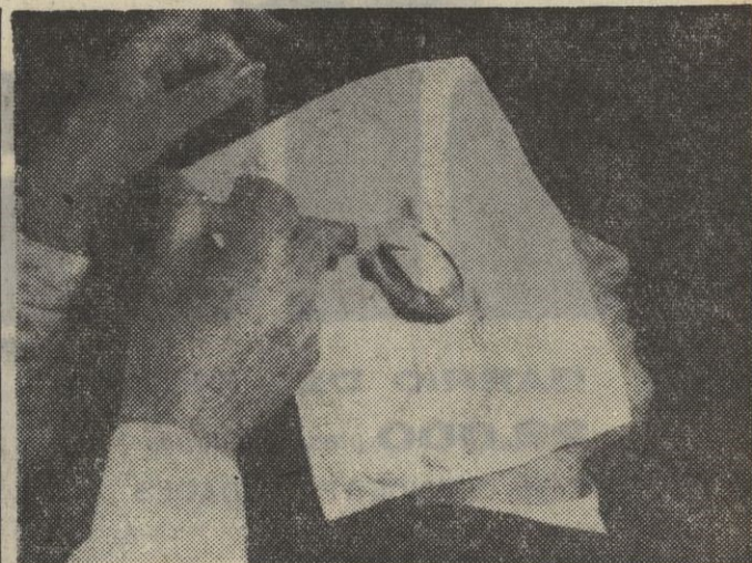
Un detalle muy importante de los audífonos o aparatos para los sordos es la oliva, que sirve de adaptador del auricular al oído. Para oír perfectamente conviene que ajuste. Por eso es menester sacar un molde o vaciado del agujero del oído externo.
