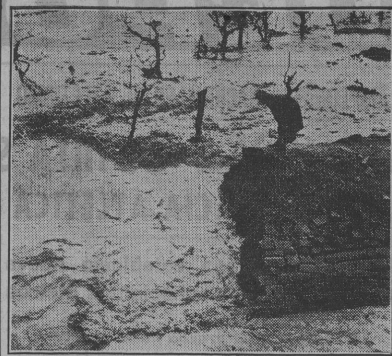
En la misma línea del frente italiano las fuertes lluvias arrastran un puente. (Foto Calpe).
