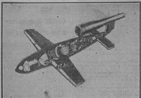
Vista de la arma secreta alemana, mezcla de proyectil-cohete y avión sin piloto. El proyectil ha sido seccionado para poder ver los mecanismos de su interior. (Foto Pando, recibida por radio.)
