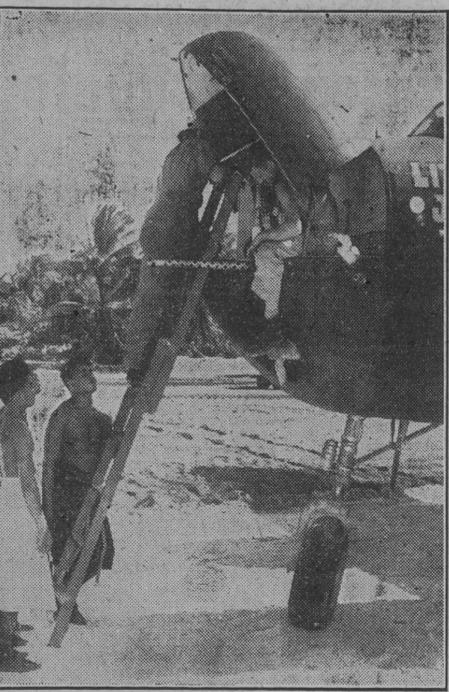
En una base aérea del Pacífico, y ante isleños de las Gilbert, el personal de tierra americano levanta la proa metálica de un bombardero medio Mitchell B-25 para cargar y ajustar las dos ametralladoras.
