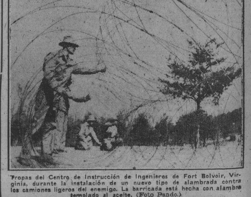
Fropas del Centro de Instrucción de Ingenieros de For Bolvoir, Virginia, durante la instalación de un nuevo tipo de alambrada contra los camiones ligeros del enemigo. La barrica está hecha con alambre templado al aceite. (Foto Pando.)
