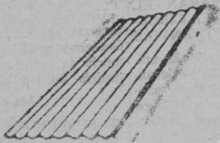
Bovedillas patentadas para la construcción de techos. Canales indestructibles que no oxidan ni alaban los de zinc, plomo etc.
