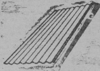
Bovedillas patentadas para la construcción de techos.
