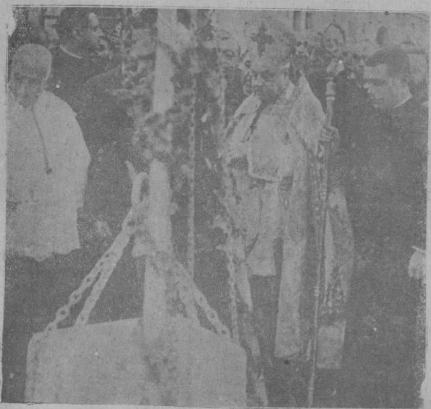
El Obispo de Barcelona, nuestro ilustre paisano Dr. Miralles, bendiciendo la primera piedra del Palacio de las Misiones
