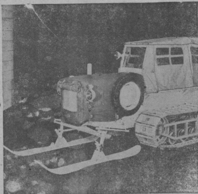
Un tractor especial—M7—del Ejército norteamericano, cuyas ruedas delanteras puede sustituirse por esquís, para servicio en las zonas árticas.
