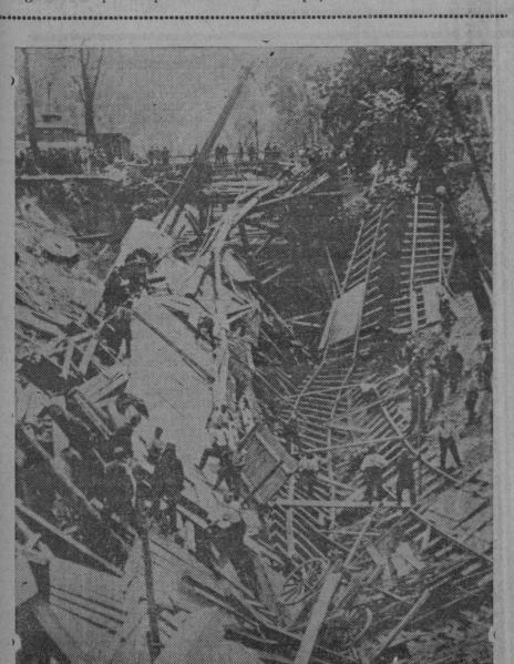
A causa del derrumbamiento del envigado, se hundió la galería de la obra del Metropolitano de Berlín, resultando numerosos obreros muertos y muchos heridos. Lugar del siniestro después del hundimiento del túnel «Hermann Goeringstrasse», durante los trabajos de descombro. (Express-Foto.)
