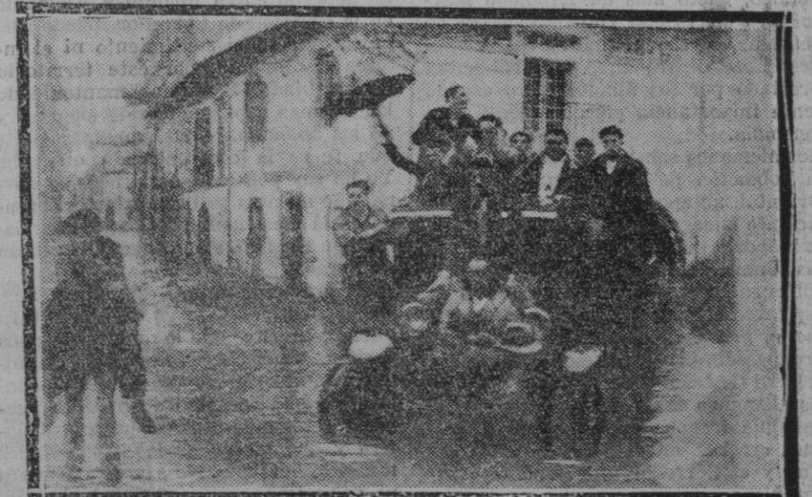
NERIN.—La enorme inundación a causa de las lluvias torrenciales. Las aguas alcanzaron a un alto nivel en el interior de las casas y algunas familias se vieron en grave peligro—En la foto un automóvil con el Alcalde (x) con agentes de policía y vecinos del pueblo recorren el pueblo prestando auxilio al vecindario.
