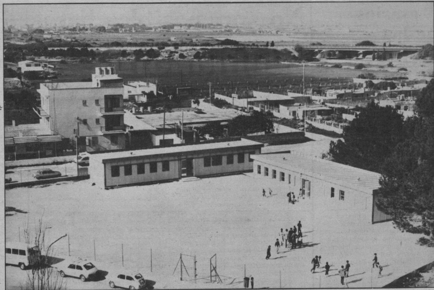
Esta es la Escuela de Ca'n Pastilla, que se encuentra en el centro de una zona eminentemente turística, ¿que pensarán los visitantes?
