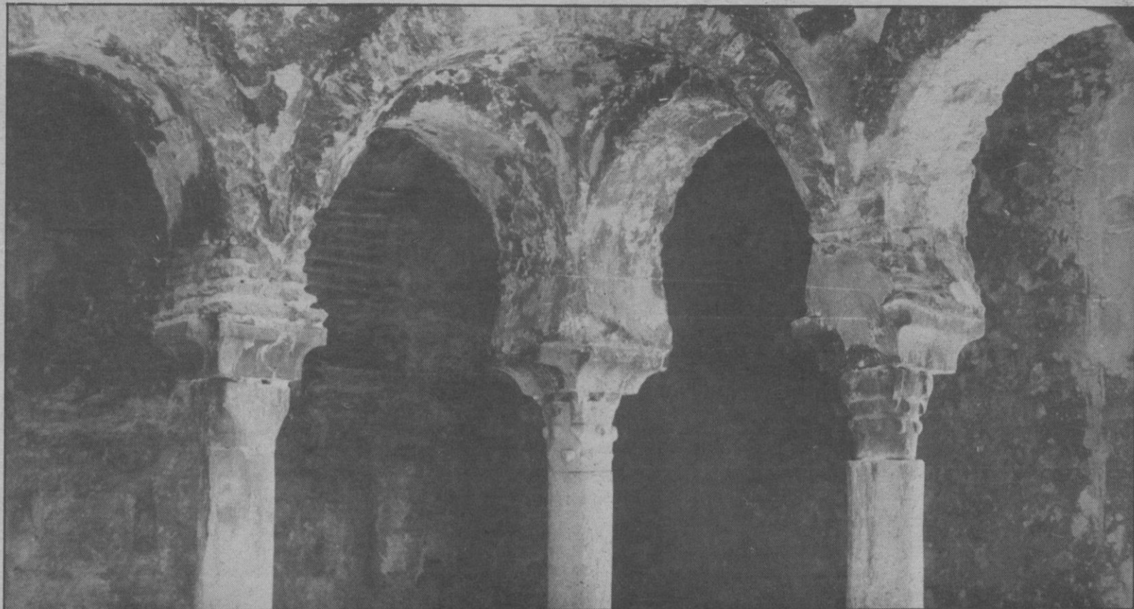
Detalle de la dependencia principal de los Baños Arabes de Palma. Su cúpula es de media naranja, sobre pechinas en los ángulos y sostenida por doce columnas. Fotos: Mascaró Pasarius.
