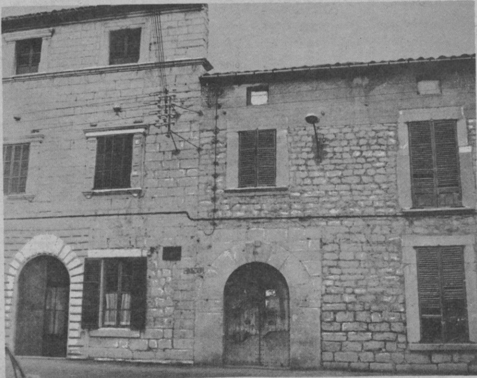
La casa de la izquierda es Ca'n Tiró de Ses Bolles. La nueva calle se hará tirando la casa de la derecha (Ca'n Garriga)
