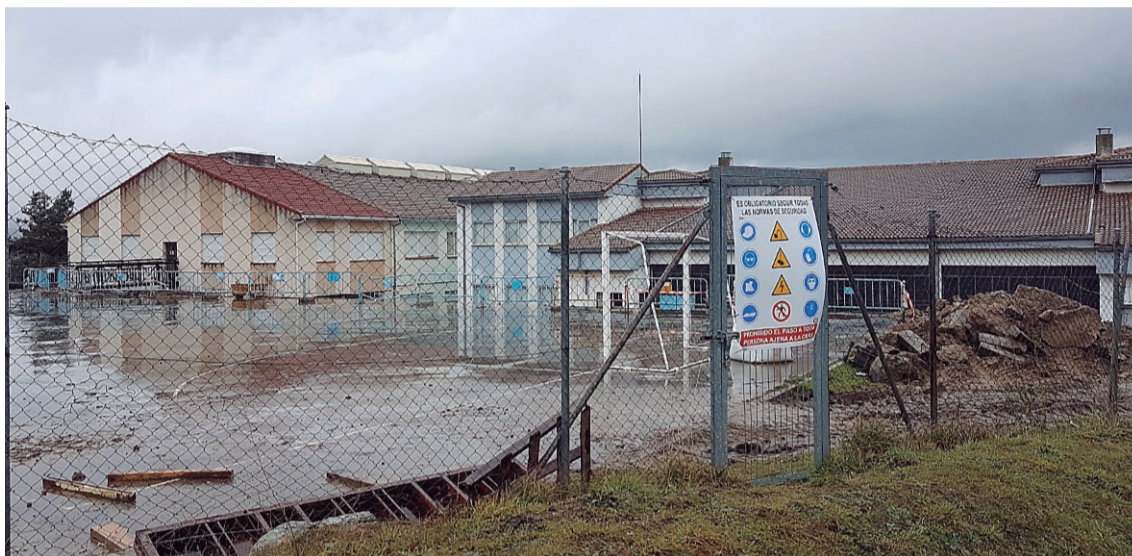
Comienzo de las obras en el instituto de El Espinar.
