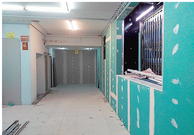
Vista del interior de la sede de Asgem, en plena reforma.
