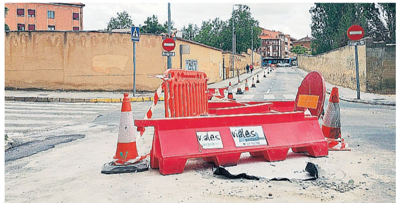
Calle del Prado, en obras hasta la conexión con Padre Claret.
