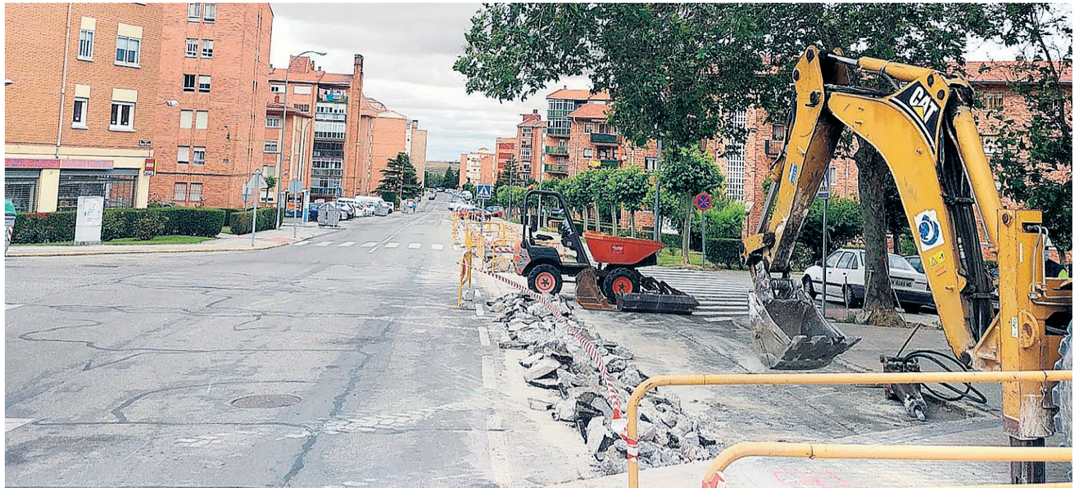
Obras de renovación de redes de abastecimiento de agua en un tramo de la avenida Marqués de Lozoya.
