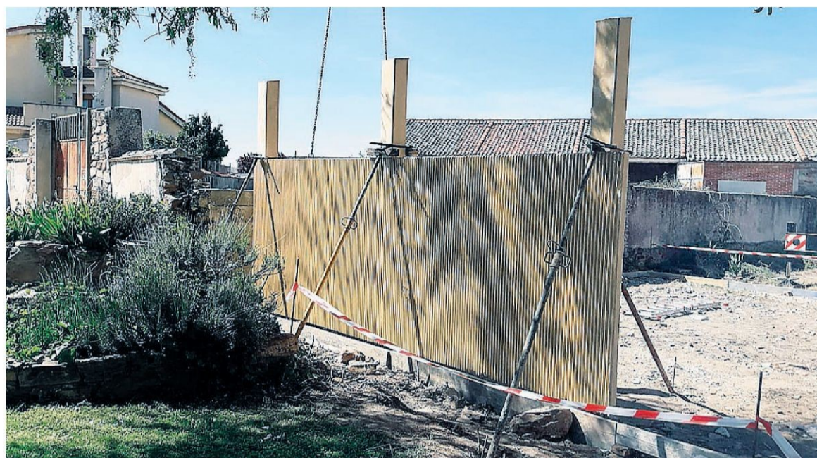
En algunos pueblos ya se están construyendo estas nuevas instalaciones.
