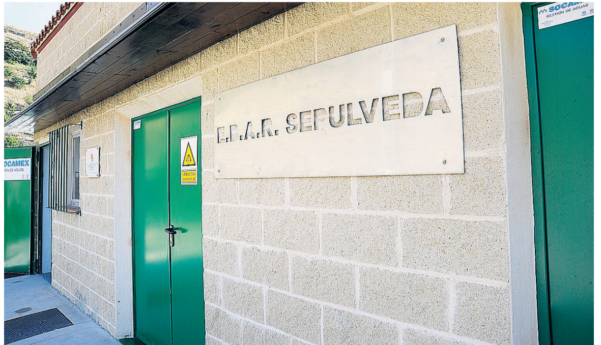
Entrada a las instalaciones de la depuradora de Sepúlveda.
