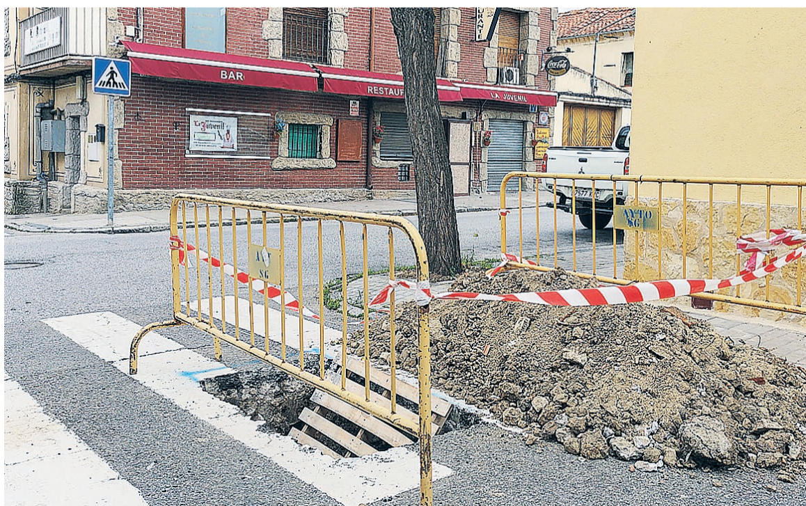
Estado de las obras ayer jueves en la calle de María del Salto, intersección con Pascual Marín.
