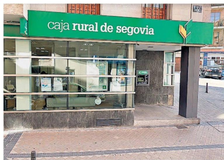
Fachada de Caja Viva en Segovia.
