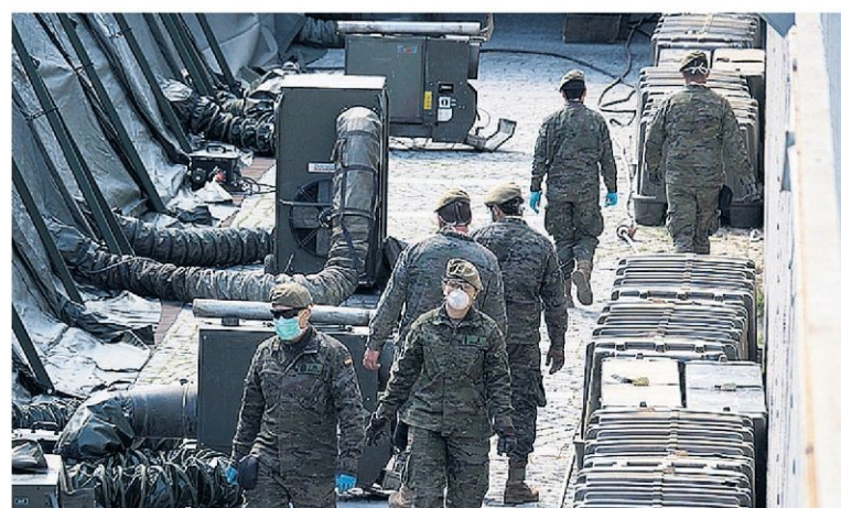
Las tiendas cuentan con climatización y red eléctrica propia.
