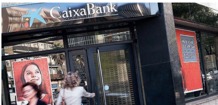
Una cliente entra en una oficina de CaixaBank.
