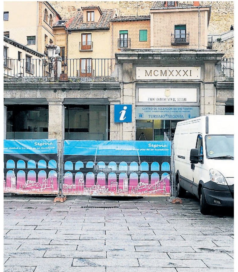
El Centro de Recepción de Visitantes, en obras desde la semana pasada.
