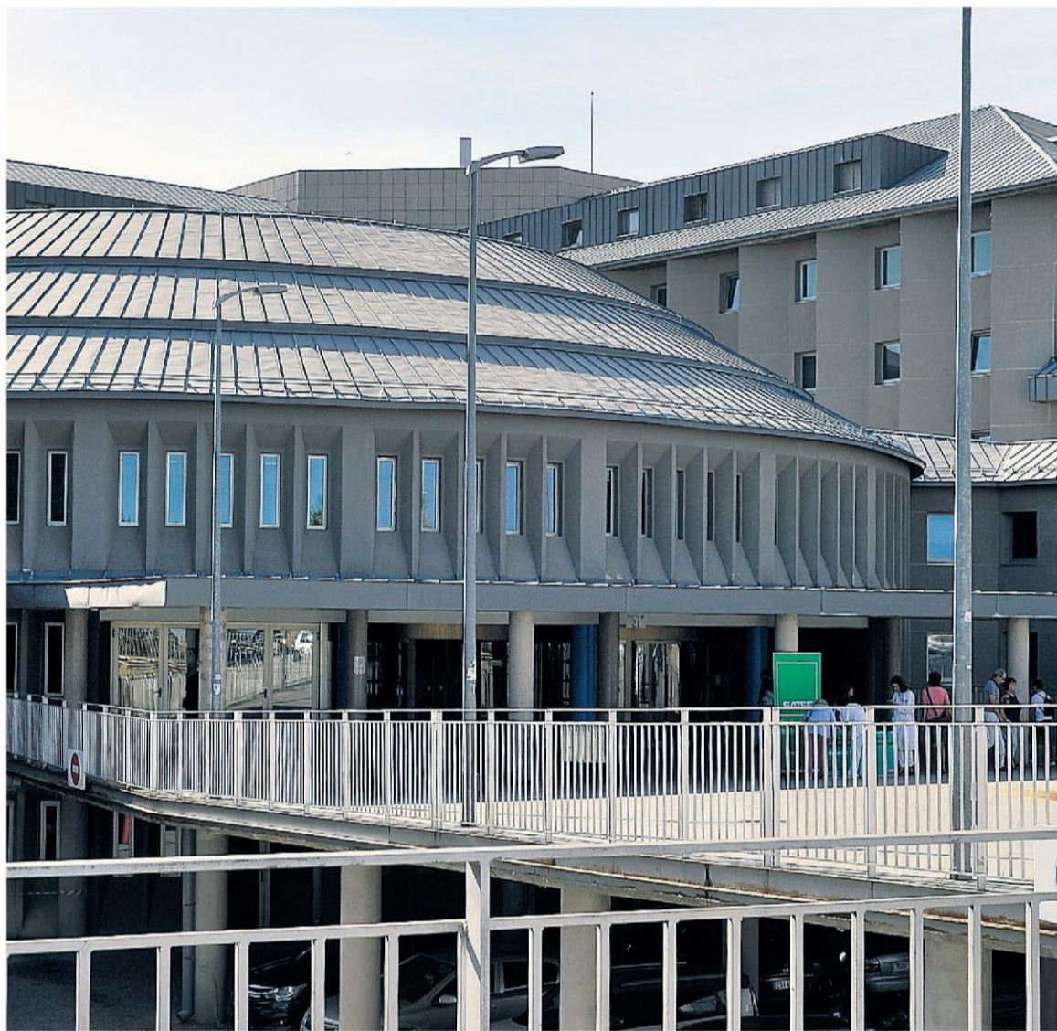
Acceso al Hospital General que pertenece al Complejo Asistencial de Segovia.
