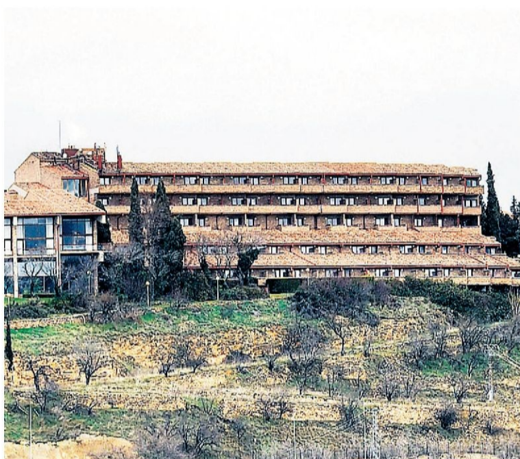
Vista general del Parador de Turismo de Segovia.
